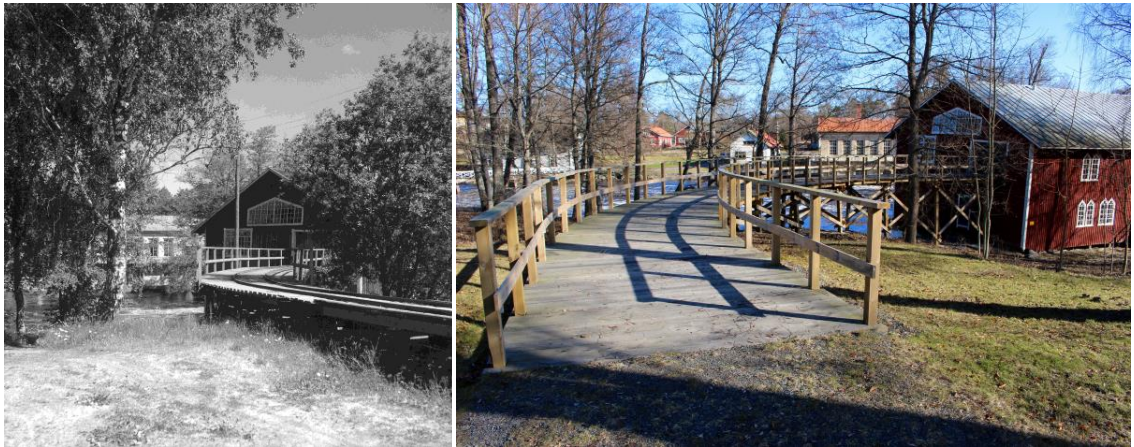
Kuva 22. Merkittävänä osana Makkarakosken sahan maisemaan on kuulunut kaarisilta, jota pitkin valmis lautatavara kuljetettiin lautatarhaan. Kuva: AAOY. Kuva 23. Kaarisilta palautettiin turvallisuusmääräysten mukaisesti osaksi sahan museoitua maisemaa keväällä 2014. Kuvat Hanna Jaakola 2016.
