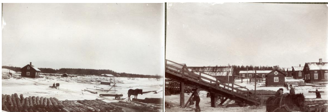
Kuva 9. Tukit varastoitiin Noormarkunjoen rannalle. Keskellä jokea oletettavasti Erkki Roslöfin kuvailema tukkilautta. Kuva 10. Tukkisiltaa pitkin sahattavat tukit nostettiin ketjupyörän avulla sahalle. Taustalla Sepänmäkenä tunnetut työläisten asunnot vuosilta 1880–1890. Kuvat: Noormarkun kotiseutuyhdistys r.y.
