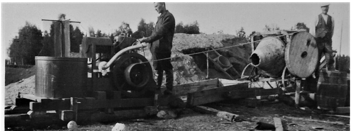
Kuvassa ehkä Vatajankosken sähkölaitoksen rakentamisessa käytetty sementin sekoitus-kone eli ”petonikone”. KKM..
