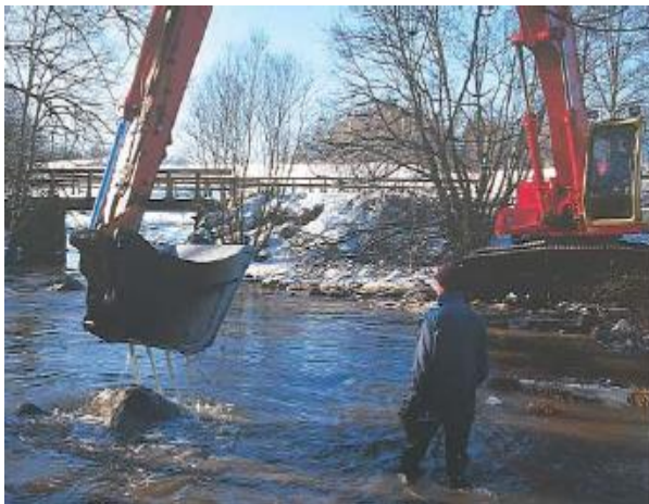
Kuva 13. Ruoppaus toteutetaan usein rannoilta käsin kaivurilla kaivamalla. Otollisin aika ruoppaukselle on talvella, sillä roudan ansiosta maaperä kestää raskaan ruoppauskaluston (kuva Pasi Lampinen).
