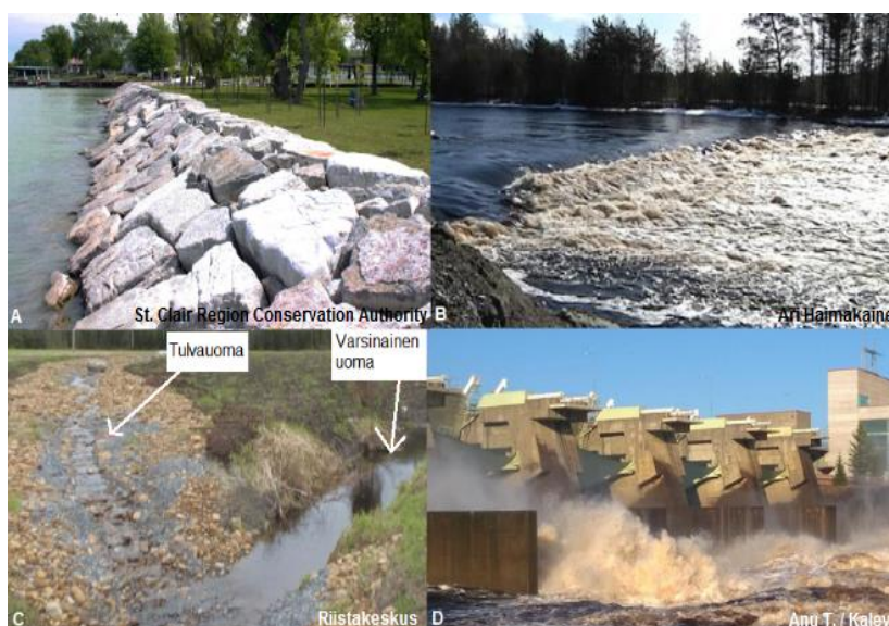
Kuva 12. Erilaisia jokuoman muokkauksen keinoja. Samoja keinoja käytetään tulvasuojelussa. A. Eroosiosuojaus estää virtaavaa vettä kuluttamasta uoman törmä. B. Pohjapadot pidättävät kiintoainesta ja nostavat vedenkorkeutta. C. Tulvauomat ohjaavat tulvatilanteessa vettä vaihtoehtoiselle reitille. D. Tulvaluukut säännöstelevät ja ohjaavat virtaavaa vettä (kuvaajien nimet kuvissa).
