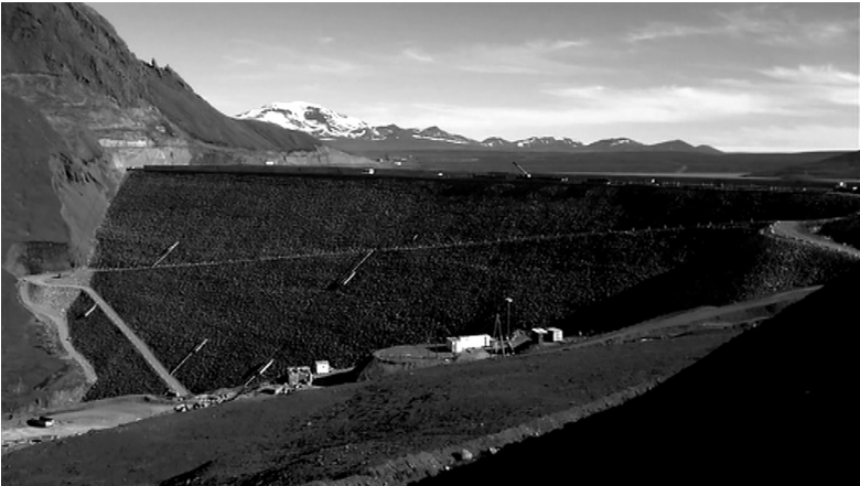
Kuva 3d. Uusi Kárahnjúkastifflan pato Kárahnjúkarin vesivoimalan alueella.
