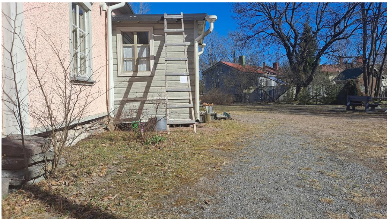
Kuva 19. Näkymä portilta ulko-ovien suuntaan kuljettaessa, suoraan edessä näkyy lännen puoleinen kuisti. Kuvattu itään päin. Karttunen, Jonna 2022
