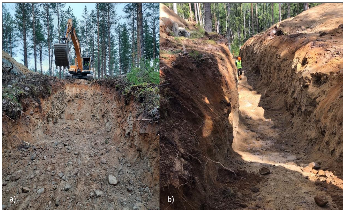
Kuva 10. a) Kesällä 2020 avattu, noin 17 m pitkä ja 3,5 metriä korkea PMR-kumpu (S1) (valokuva: Joni Mäkinen) ja b) vuonna 2021 avattu, noin 45 m pitkä ja 3,2 metriä korkea PMR-kumpu (S2). Kohteet sijaitsevat 265 m päässä toisistaan Kiramonsuon PMR-kentän keskiössä.
