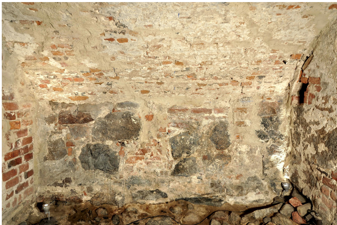
Kuva 20. Kellarin K93:3 luoteisseinä ja osa tynnyriholvattua kattoa. Kuva: Markus Kivistö.
