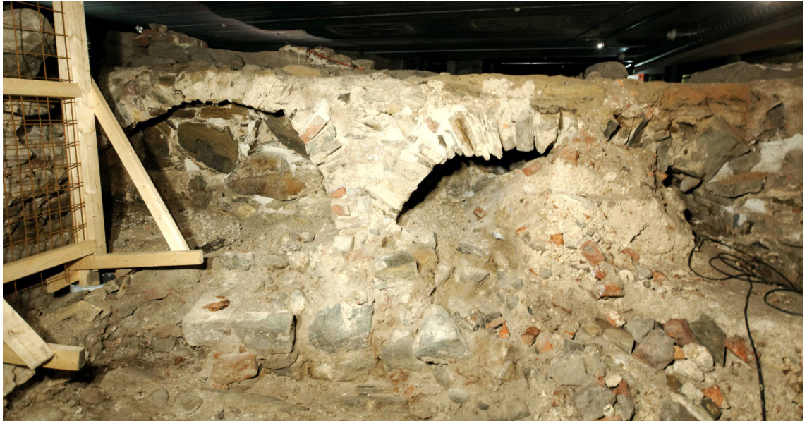
Kuva 30. Kellarin K94:9 lounaisseinä. Lähes kaikki kellarin kivimateriaali on kiillegneissia, jota on niin seinissä kuin seinäkomeroiden holvikatoissa. Aboa Vetus & Ars Nova -museon sisääntuloaulassa. Kuva: Markus Kivistö.
