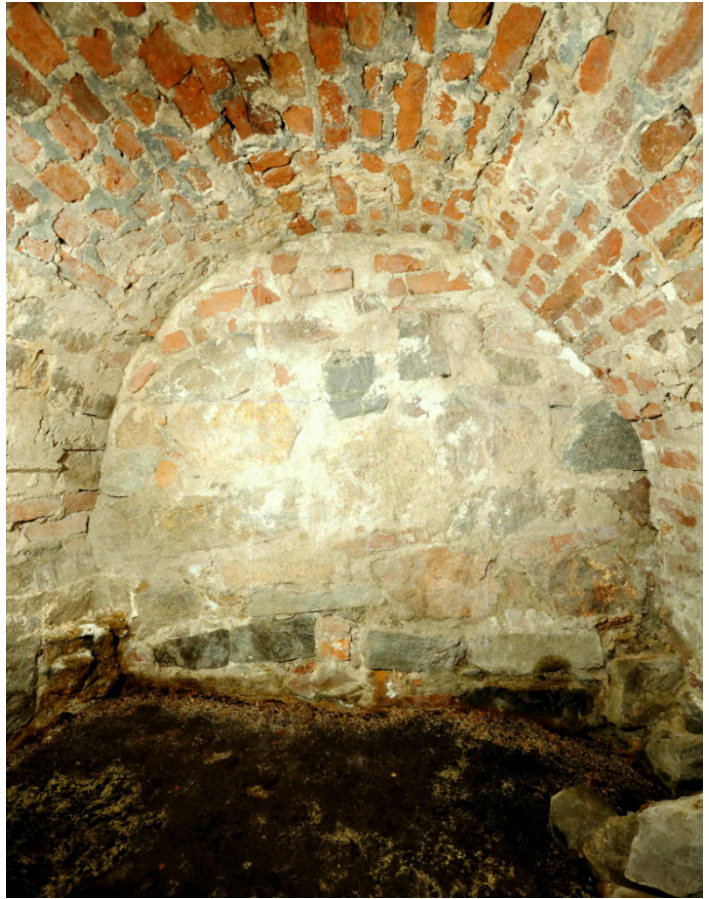
Kuva 18. Kellarin K93:5 koillisseinää ja tynnyriholvattu katto. Kuva: Markus Kivistö.
