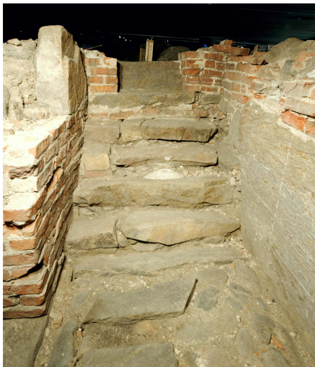
Kuva 28. Kellari K94:11. Portaat on tehty muotoilluista rakennuskivistä ja johtavat kellariin K94:12 (oviaukko kuvassa vasemmalla). Oikealla puolella kuvaa yksi suurimpia rakennuskivilohkareita Aboa Vetus & Ars Nova -museossa. Kintsigiittilohkareen koko on n. 1,2 m x 2,2 m, leveys tuntematon. Kuva: Markus Kivistö.
