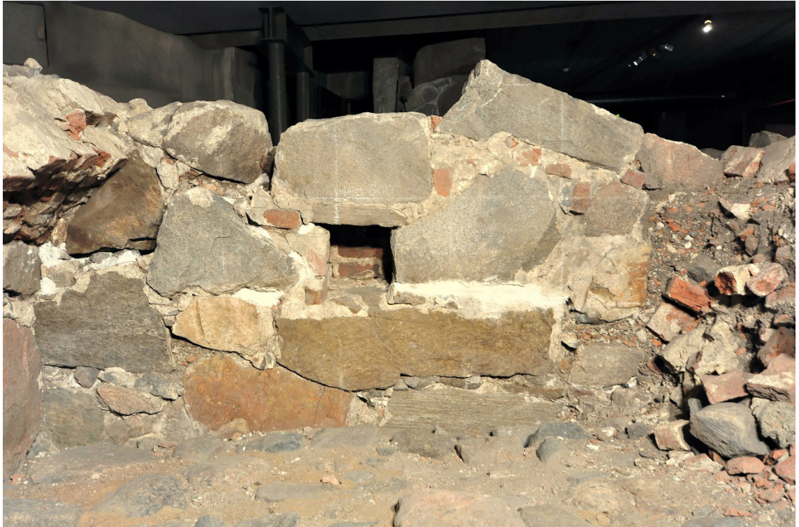
Kuva 26. Suuria sekä selvästi halkaistuja ja muotoiltuja rakennuskiviä kellarin K94:12 lounaisseinässä. Kuva: Markus Kivistö.
