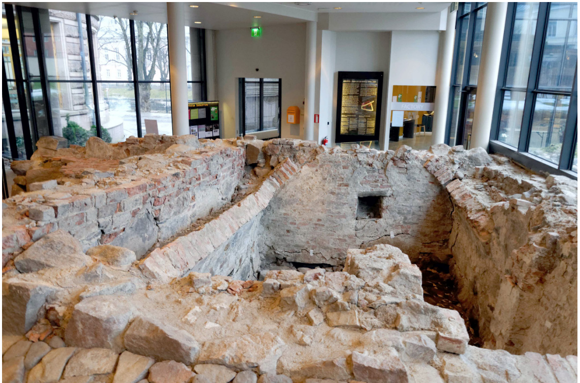
Kuva 10. Kellari K92:6 Aboa Vetus & Ars Nova -museon sisääntuloaulassa. Seinien yläosa ja tynnyriholvikatto on muurattu tiilistä. Lattia on katettu nupukivillä (läpimitta n. 10–20 cm), jotka ovat pääosin pyörityneitä irtokiviä. Kuva: Markus Kivistö.
