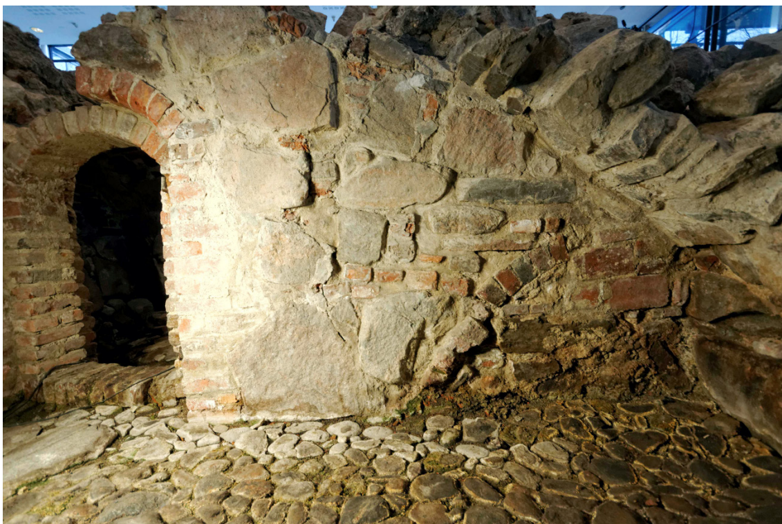
Kuva 12. Kellarin K92:3 pohjoisseinä. Lattia on katettu nupukivillä (läpimitta n. 10–20 cm) kuten kellarissa K 92:6. Kuva: Markus Kivistö.
