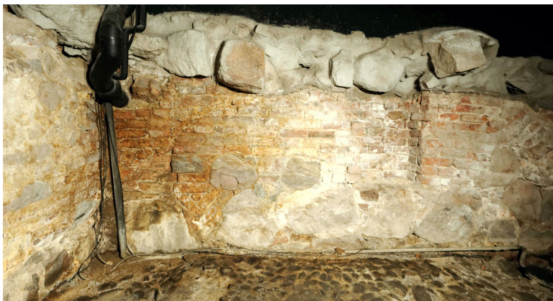
Kuva 24. Kellarin K94:7 länsikulma ja samalla kaikkein läntisin kulma koko Aboa Vetus -museosta. Suuria rakennuskiviä on käytetty seinän alaosassa. Kuva: Markus Kivistö.
