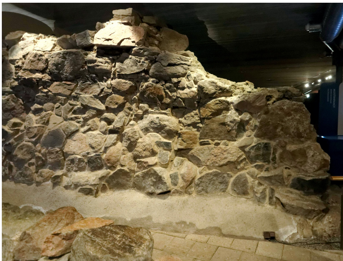
Kuva 32. Kellarin K94:10 koillista ulkoseinää. Rakennuskivien muoto on hyvin pyöreä, ja monet suurimmistakin saattavat olla halkaistuja irtokiviä. Kuvan vasemmassa alareunassa sijaitsevan kaivon kivien analyysijä ei sisällytetty tutkimuksen tarkasteluun Kuva: Markus Kivistö.
