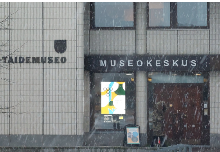
Kuva 3: Hämeenkadun puoleinen pääsisäänkäynti
