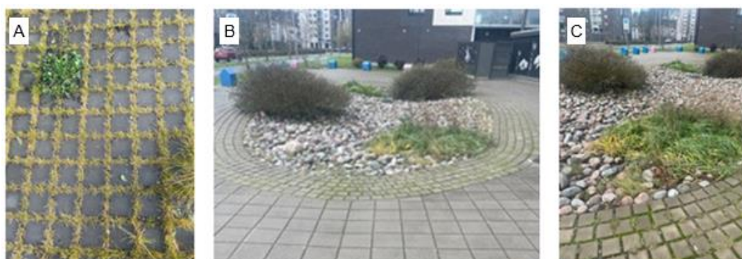
Kuva 12. Nurmikivetyksen hyödyntäminen osana hulevesiratkaisuja. A. Vuonna 2021 valmistuneen verrokkikohteen 14D nurmikivetys. B ja C vuonna 2018 valmistuneen verrokkikohteen 13D hulevesipainanne ja nurmikivetys.
