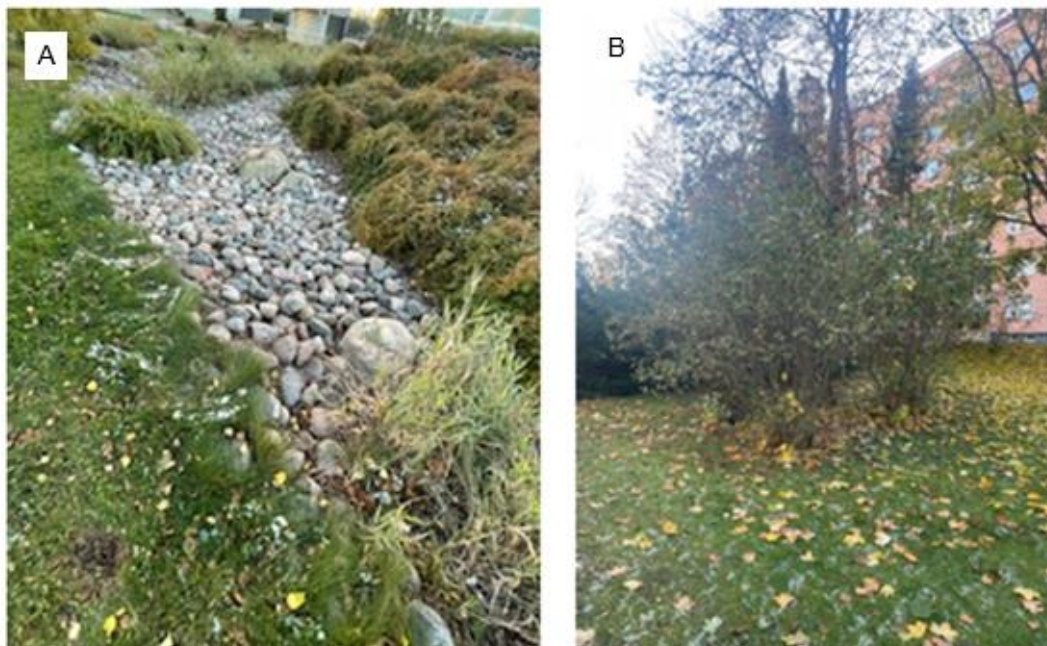
Kuva 10. Verrokkikohteilla olleita sinivihreän infrastruktuurin ratkaisuja. A. Vuonna 2017 valmistuneen verrokkikohteen 13C hulevesipainanne. B. Vuonna 1956 valmistuneen kohteen pihapiirissä olleet pensaat.
