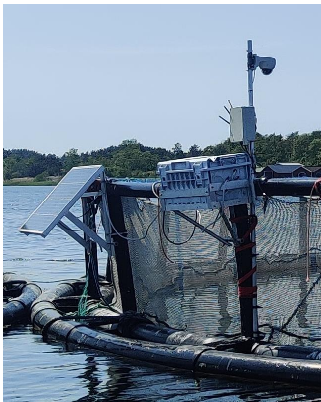
Kuva 2 Kameralaitteisto asennettuna tutkimuskohteeseen.
