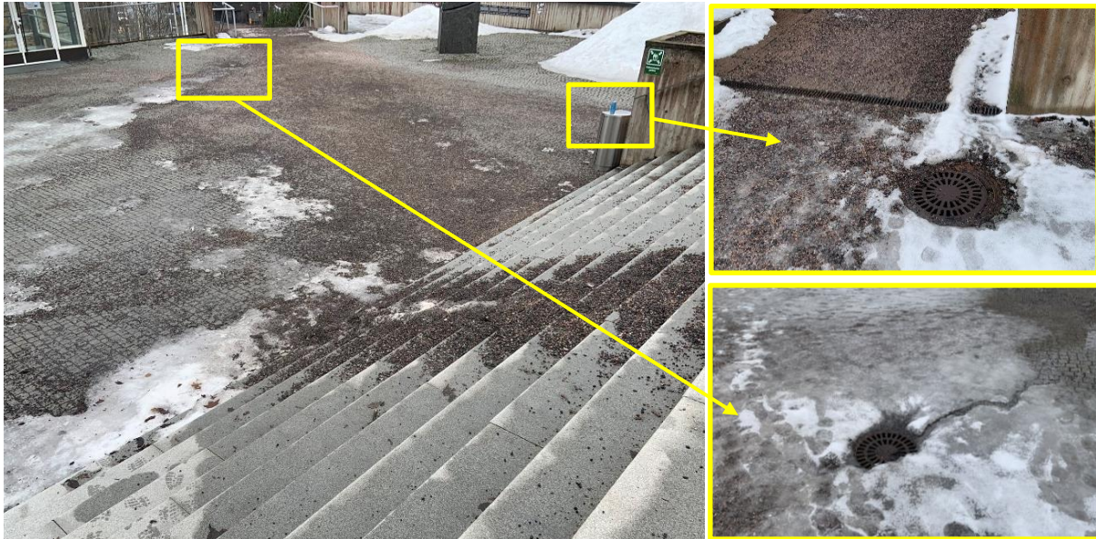
Kuva 6. Havainnointipisteen 4 hulevesikaivoja. Vasemmalla oleva suurempi kuva havainnollistaa hulevesikaivojen sijainteja. Oikealla olevat kuvat näyttävät kaivot tarkemmin. Oikealla olevista kuvista voi myös hahmottaa, kuinka kaivojen ympärillä olevat sulamisvedet suuntaavat kaivoja kohti.
