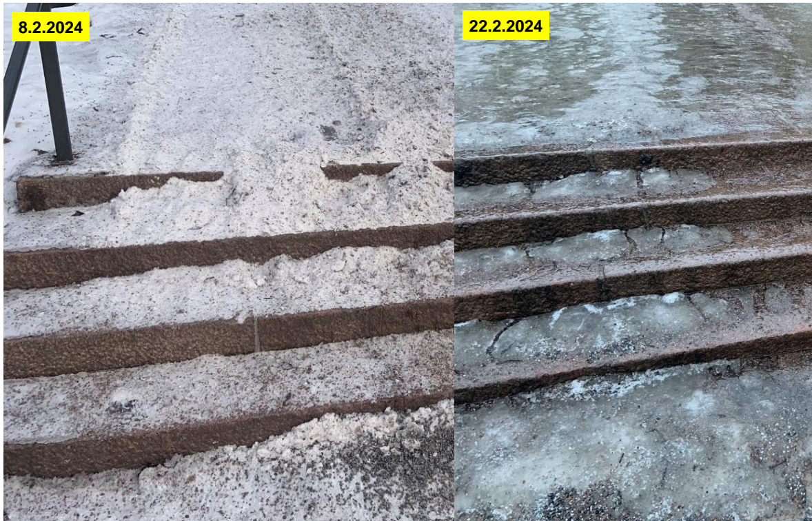
Kuva 7. Esimerkki huleveden lähteistä havainnointipisteeltä 1. Kuvassa on samat portaat eri havainnointipäivinä. Vasemmanpuoleisessa kuvassa portaille on kasattu lunta ja jäämurskaa. Oikeanpuoleisessa kuvassa sama lumi ja jää on sulanut kaksi viikkoa myöhemmin hulevesiksi. Vesi virtaa kuvassa portaita pitkin ja kasautuu portaiden välitasanteille. Sulamisvesi sitten jäätyy portaille uudestaan, minkä takia portaat ovat liukkaat.
