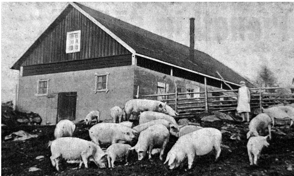
Kuva 17. Ajan ihanteiden mukainen juoksutarha: se oli sikalan välittömässä läheisyydessä ja riinteeseen sijoitettuna, jolloin se pysyi suhteellisen kuivapohjaisena. A. Venäläinen sikala, Hammaslahti. Lähde: Suomen sianjalostusyhdistyksen tiedonantoja 32, 1933.
