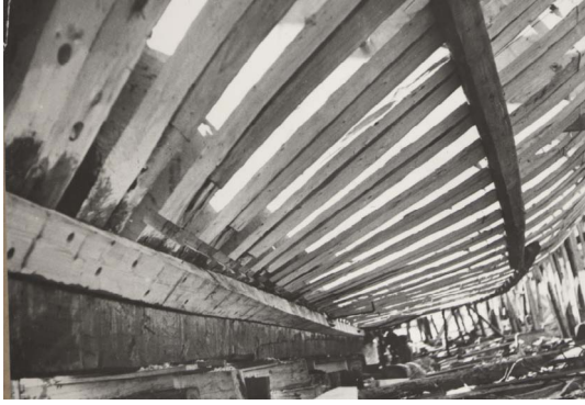
Kuvat 47–48. Vasemmalla punninkilankku on paikoillaan. Oikealla kaksi kuunaria on lankutettu, kolmannen keularanka on pystyssä takana. Kuvat RMA.
