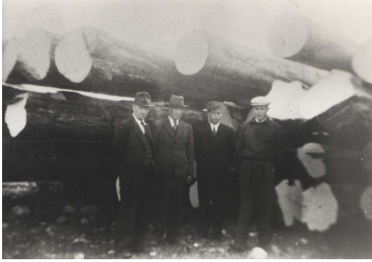
Kuva 24. Kuunarin rakennuspuista ja vasem- malla puiden hankinnasta vastannut August Mannonen. Kuva RMA.
