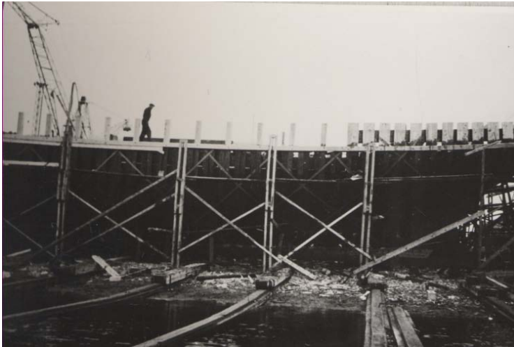
Kuva 46. Diagonaalit on jo asennettu laivan kylkeen, seuraava työvaihe on lankutus. Kuva RMA.
