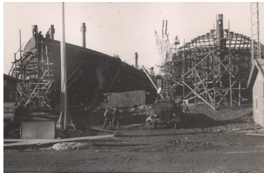
Kuva 98. Teräsproomut rakenteilla. Kuva RMA.
