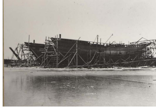
Kuvat 47–48. Vasemmalla punninkilankku on paikoillaan. Oikealla kaksi kuunaria on lankutettu, kolmannen keularanka on pystyssä takana. Kuvat RMA.
