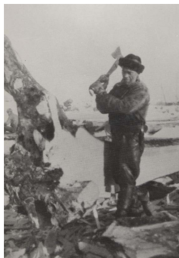
Kuva 31. Keulajuurikasista veistämässä. Kuva RMA.
