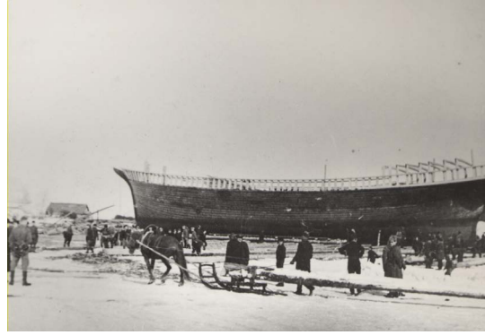
Kuvat 66–67. Vasemmalla (etualalla) palkit, joita pitkin sotakorvauskuunari on juuri laskettu veteen kylki edellä. Oikealla kuunari Koiviston vesillelaskua valmistellaan tammikuussa 1944. Kuvat RMA.
