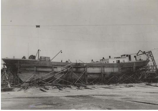
Kuvat 49–50. Vasemmalla kylkilankutus on valmis, kansirakenteita tehdään. Oikealla kyljen lankutusta rivetään. Kuvat RMA.
