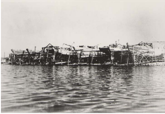
Kuvat 64–65. Vasemmalla kuutta kuunaria rakennetaan rinnakkain, kahden puolen rullatelakkaa. Kaksi kuunaria rakentuu perä merelle, muut laskettiin vesille keula edellä. Oikealla Hollmingin telakan ensimmäinen teräslaiva Vilppo koristeltuna vesillelaskua varten. Kuvat RMA.
