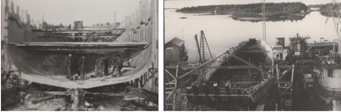
Kuvat 41–42. Vasemmalla kaaria leksitään, sentteriu'ut tukevat vielä kaaria. Oikealla viimeinen Hollmingin sotakorvauskuunareista on kaarittuna. Kuvat RMA.
