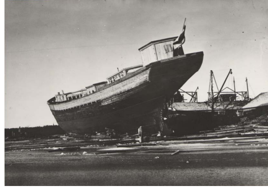
Kuva 60. Laiva on valmiina vesillelaskuun, vaikka kansirakenteet ovat vielä keskeneräiset. Jäävuoraus ja matopohja erottuvat selvästi. Kuva RMA.
