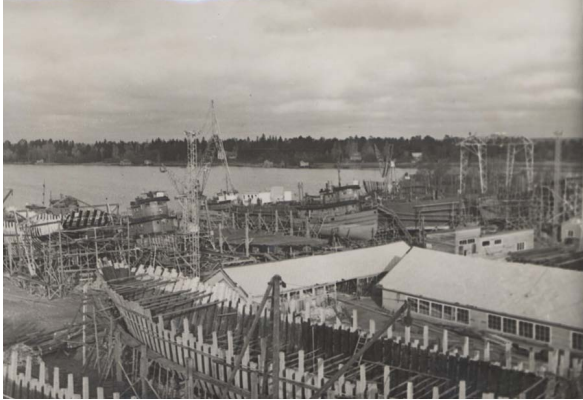
Kuva 55. Etualalla laivan toinen parikaarista on jätetty reilinkitötäksi. Taustalla hinaajat, joita telakalla korjattiin. Kuva RMA.
