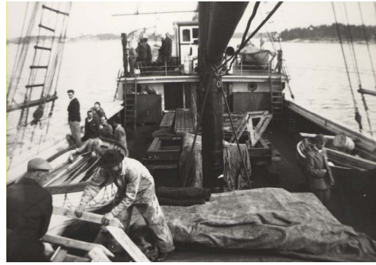
Kuva 91. Koeajon aikana rakennetaan pelastusveneen petiä. Kuva RMA.
