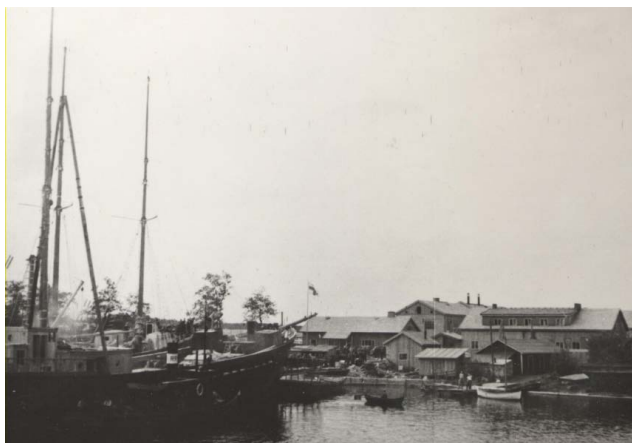
Kuva 70. Vasemmalla kuunarin mastoa nostetaan saksien avulla. Lipputangon oikealla puolella telakan konttori, sen jälkeen konepaja ja ruokala (iso rakennus), etualalla varastoja. Kuva RMA.
