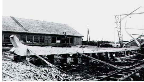
Kuva 32. Kölipuut on nostettu petipukkien päälle, keulajuurikas etualalla. Nollakaarta nostetaan kölille, pukkien avulla se kuljetetaan rataa pitkin keulaan. Taustalla kaarilava. Kuva RMA.
