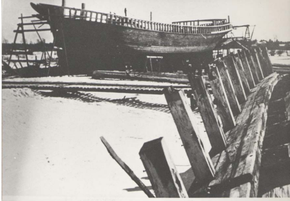
Kuva 5. Kuunari Koiviston runko on reilinkä vaille valmis. Etualalla vuonna 1919 rakennetun Pohjantähden hylky. Kuva RMA.
