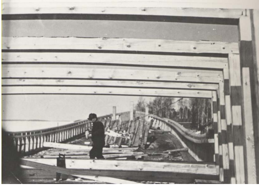
Kuva 13. Kuunari Koiviston kansirakenteita valmistelemassa Reino Kukko. Kuva RMA.
