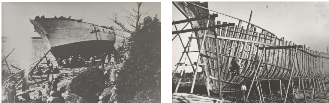
Kuvat 11–12. Saarentähden vesillelaskua valmistellaan. Kuunari Koiviston kaaritus on valmis. Tältä alus näytti, kun Koivusaari vallattiin takaisin jatkosodassa. Kuvat RMA.
