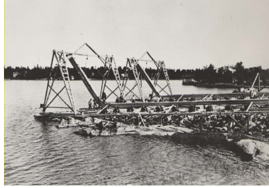
Kuvat 33–34. Vasemmalla ensimmäisen kuunarin keulatievi nousee pukkinosturin avulla. Oikealla kahden ensimmäisen sotakorvauskuunarin keularangat ovat paikoillaan. Kuvat RMA.
