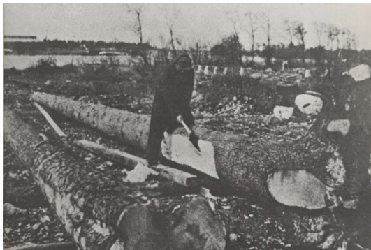
Kuva 30. Ensimmäisen sotakorvauskuunarin kölinveisto alkaa, veistäjänä Reino Kukko, josta sittemmin tuli telakan ylimestari. Telakka-alue on täysin rakentamaton. Kuva RMA.
