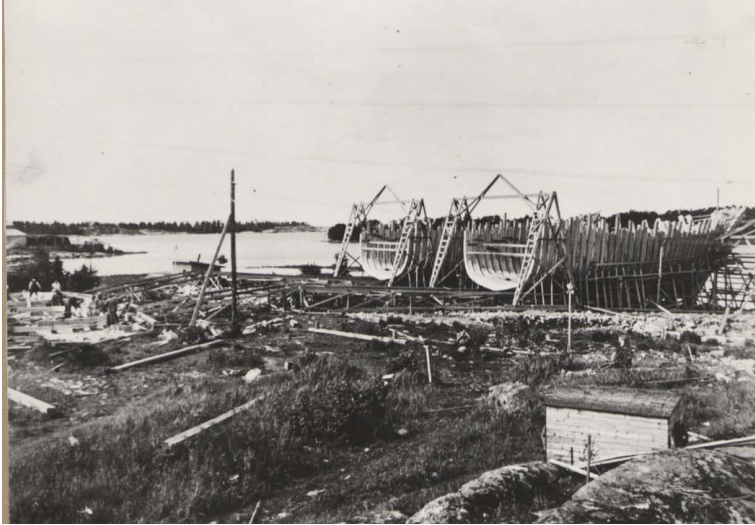
Kuva 37. Avoin kaarilava (vas.), siitä johtavat juoksut laivaan. Kuva RMA.
