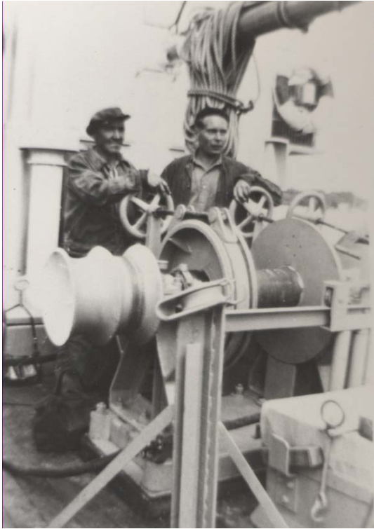
Kuva 92. Ankkurikoe menossa. Kuva RMA.
