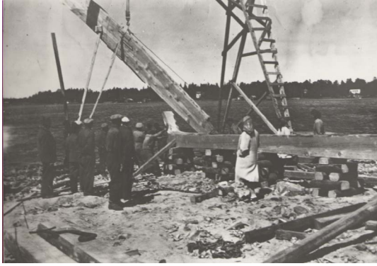
Kuvat 33–34. Vasemmalla ensimmäisen kuunarin keulatievi nousee pukkinosturin avulla. Oikealla kahden ensimmäisen sotakorvauskuunarin keularangat ovat paikoillaan. Kuvat RMA.
