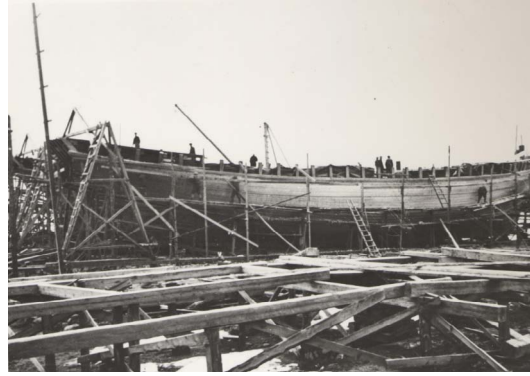
Kuvat 49–50. Vasemmalla kylkilankutus on valmis, kansirakenteita tehdään. Oikealla kyljen lankutusta rivetään. Kuvat RMA.
