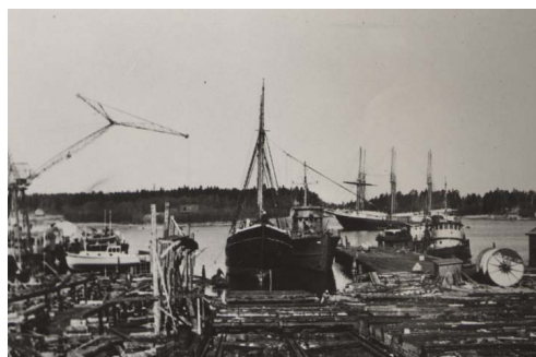
Kuvat 62–63. Vasemmalla sotakorvauskuunarin vesillelasku keula edellä. Laiva on ilmeisesti juuttunut kiinni ja sitä yritetään irrottaa. Oikealla (etualalla) rullatelakka. Kuvat RMA.
