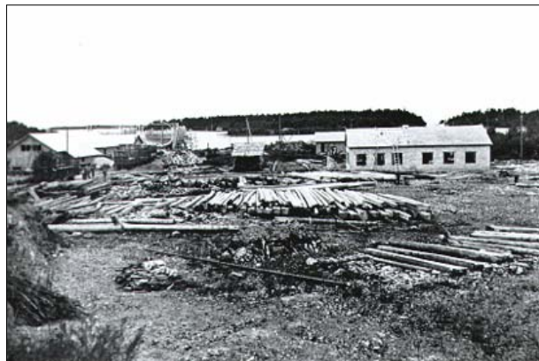
Kuva 107. Telakka-alue vuonna 1945. Vasemmalla saha ja höyläämö, sen takana kaarilava ja ensimmäiset rakenteilla olevat kuunarit. Puolivalmis tiilirakennus oikealla sisälsi pajan ja koneistamon ja se valmistui 1946. Sen takana on ensimmäinen, lautarakenteinen paja. Kuva RMA.
