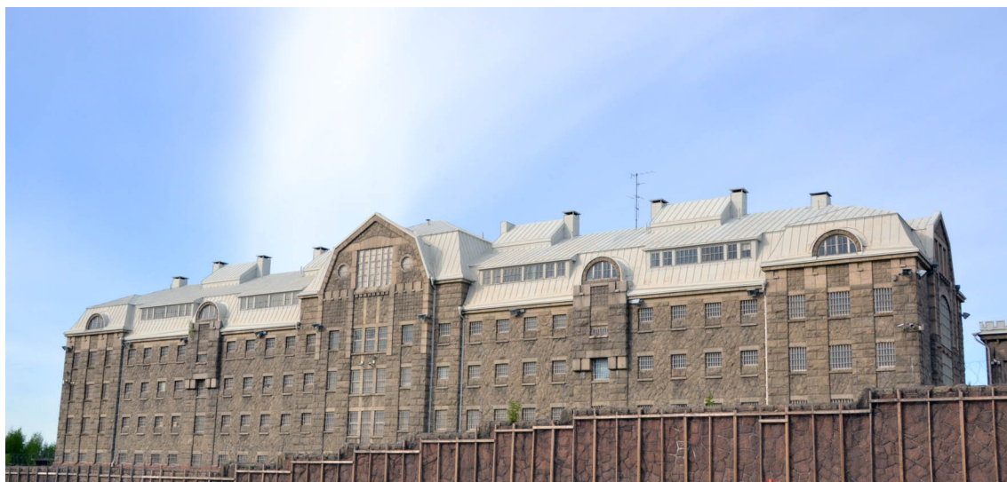
Vuonna 1912 valmistunut länsisellirakennus keväällä 2012. Ulkomuurin ympärille on laitettu tukirakenteita alueella tehtävien korjaustöiden vuoksi. Kuva: Anne Nieminen 2012. Kuva tekijän hallussa.
